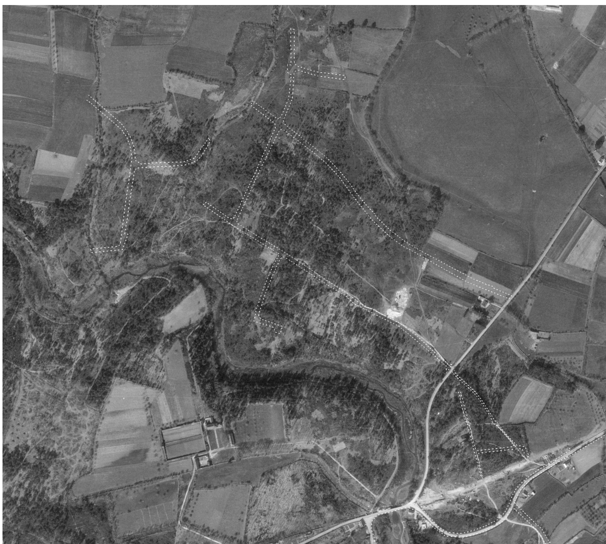
1960 : Le Boulevard des Îles est en chantier au Sud et une carrière s'est ouverte au dessus de la future branche Sud de l'Allée.
